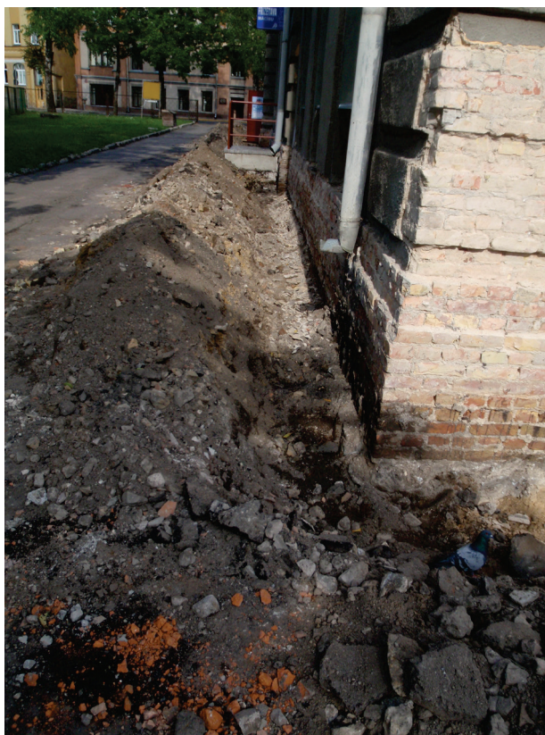
5.4. .att. Pēc poligrāna apmetuma noņemšanas ir jāatjauno apmetums, bet siltumizolācijas kārtai ir jāatkārto vēsturisko pilastru un stūru rusta raksts. (foto A. Ziemeļniece)
