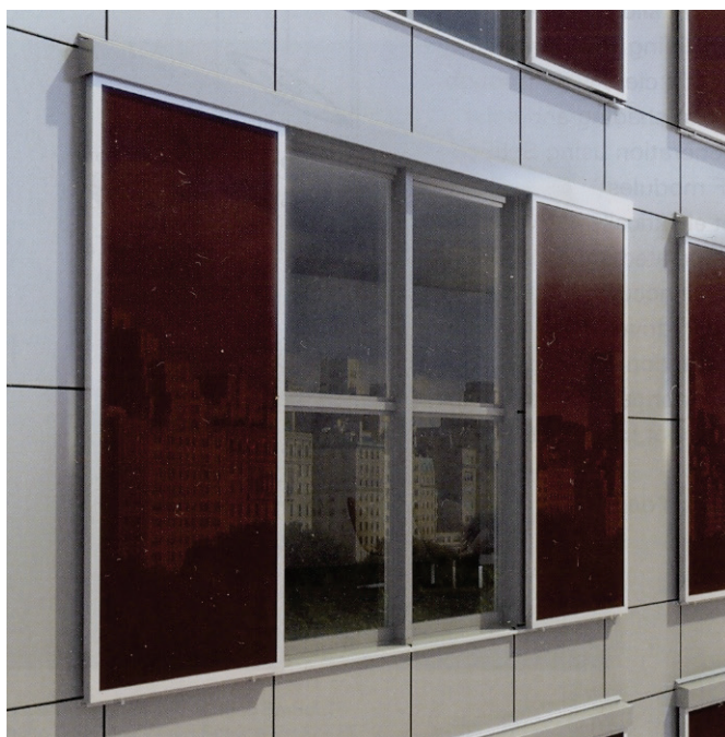
5.5. att. Izmantojot vēsturisko logu slēgu formu, tiek nostiprināti siltumenerģijas uzkrāšanas paneļi pie fasādes. (Schuco risinājums)
