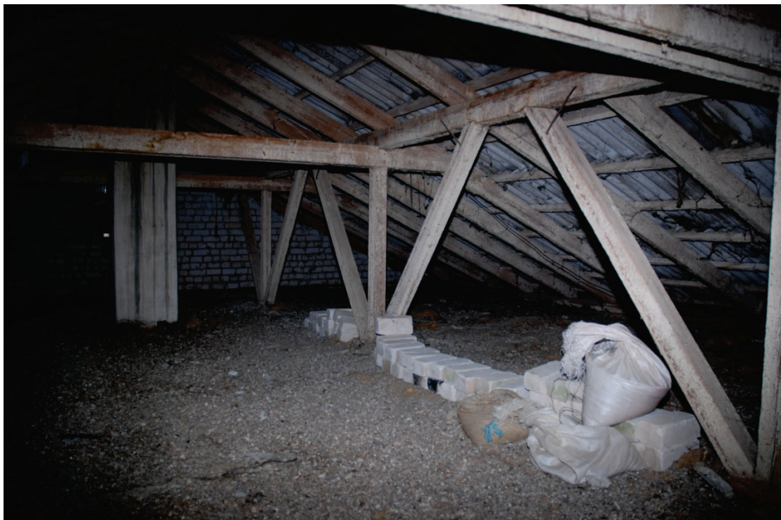
7.8. att. 316. Sērijas dzīvojamās ēkas nesošās koka jumta konstrukcijas (foto R. Brencis)
