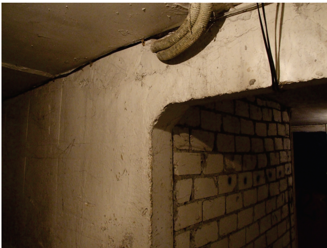
7.11. att. 602 sērijas Daudzīvokļu dzīvojamā ēkas pamati (foto R. Brencis)
