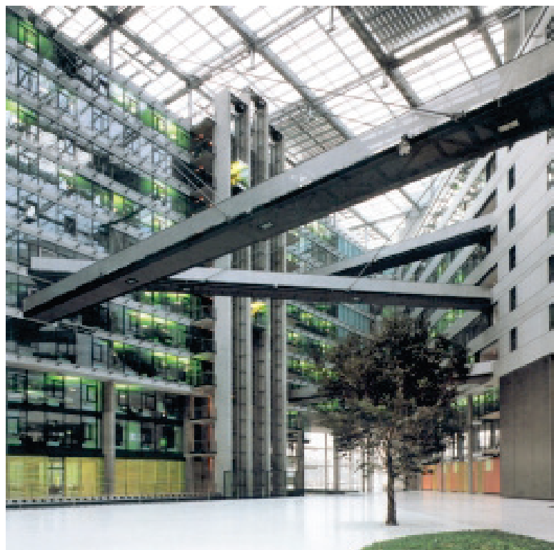
4.7. att. Frankfurtes pie Mainas Prisma biroju ēkas ātrijs. Arhitekti Auer+Weber+Partner, (2002). Pateicoties mērenajam klimatam, no visām pusēm ieskaustais ātrijs kļuvis par daudzpusīgi izmantotu iekštelpu. ( http://aileslogi.lv )
