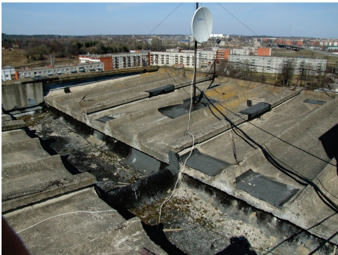
7.13. att. 602 sērijas Daudzīvokļu dzīvojamā ēkas Jumta konstrukcija (foto R. Brencis)
