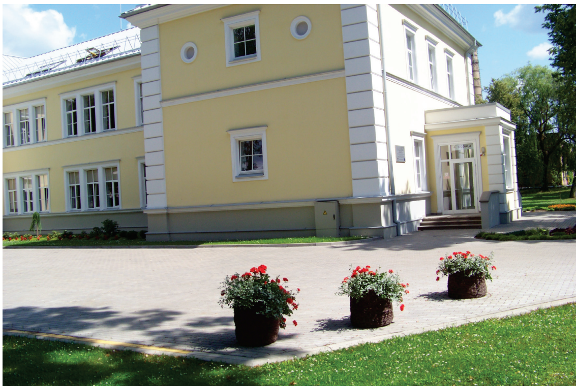
5.1. att. Ģintermuižas slimnīcas korpuss Jelgavā. Ēkas vēsturisko ārsienu siltināšana no telpu iekšpuses, ārpusē veicot kaļķu javas apmetuma remontu un pārkrāsošanu. (foto A. Ziemeļniece)
