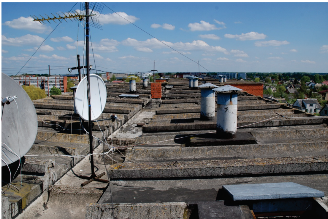
7.4. att. Jumta paneļi bez ruberoīda seguma (foto R. Brencis)
