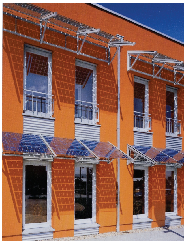
4.5. att. Enerģijas uzkrāšanas fotovoltāžas paneļi uzjumteņu formā – arhitektoniski veiksmīgs dizaina elementu izvietojums ēkas fasādē (Schuco risinājums)
