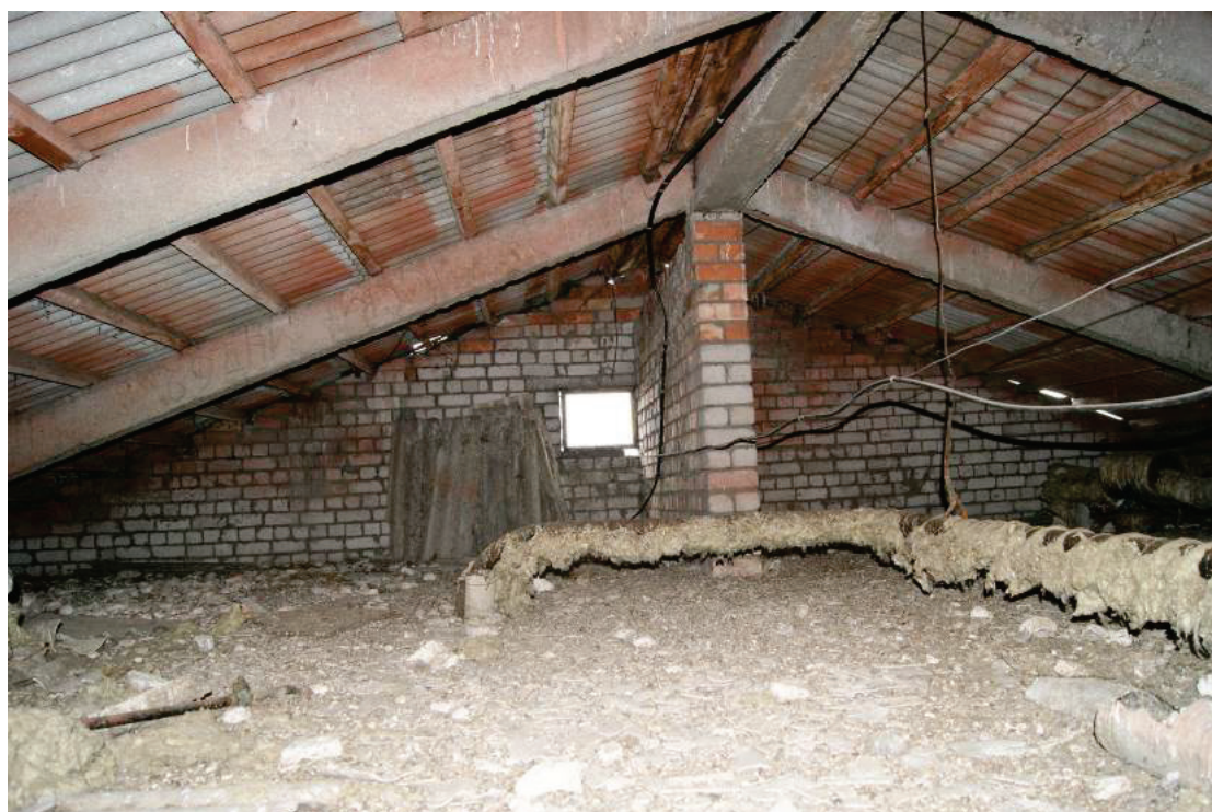
7.9. att. 316. Sērijas dzīvojamās ēkas nesošās dzelzsbetona jumta konstrukcijas (foto R. Brencis)
