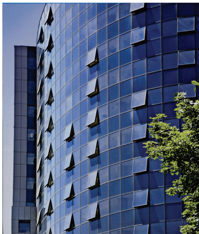
4.8. att. Fotovoltāžas paneļi kā dekoratīvi elementi ienes ēkas arhitektoniskajā risinājumā akcentu, uzirdinot fasādes stiklojuma plakni un padarot to interesantāku. (Schuco risinājums)
