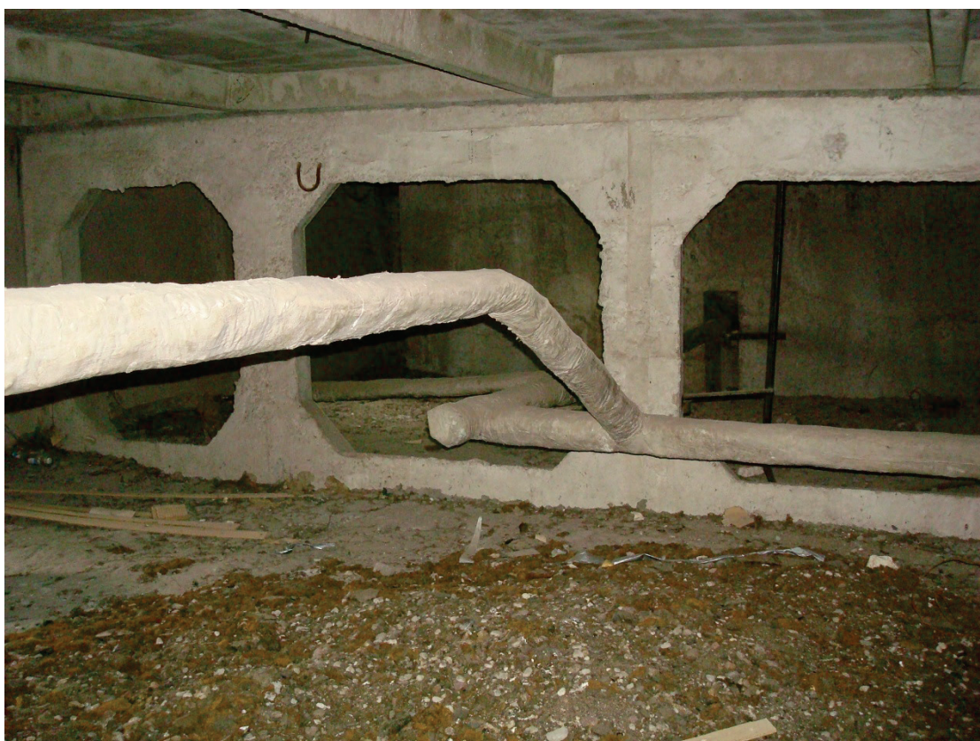
8.14. att. 602 sērijas Daudzīvokļu dzīvojamā ēkas nesošās jumta konstrukcijas (foto R. Brencis)
