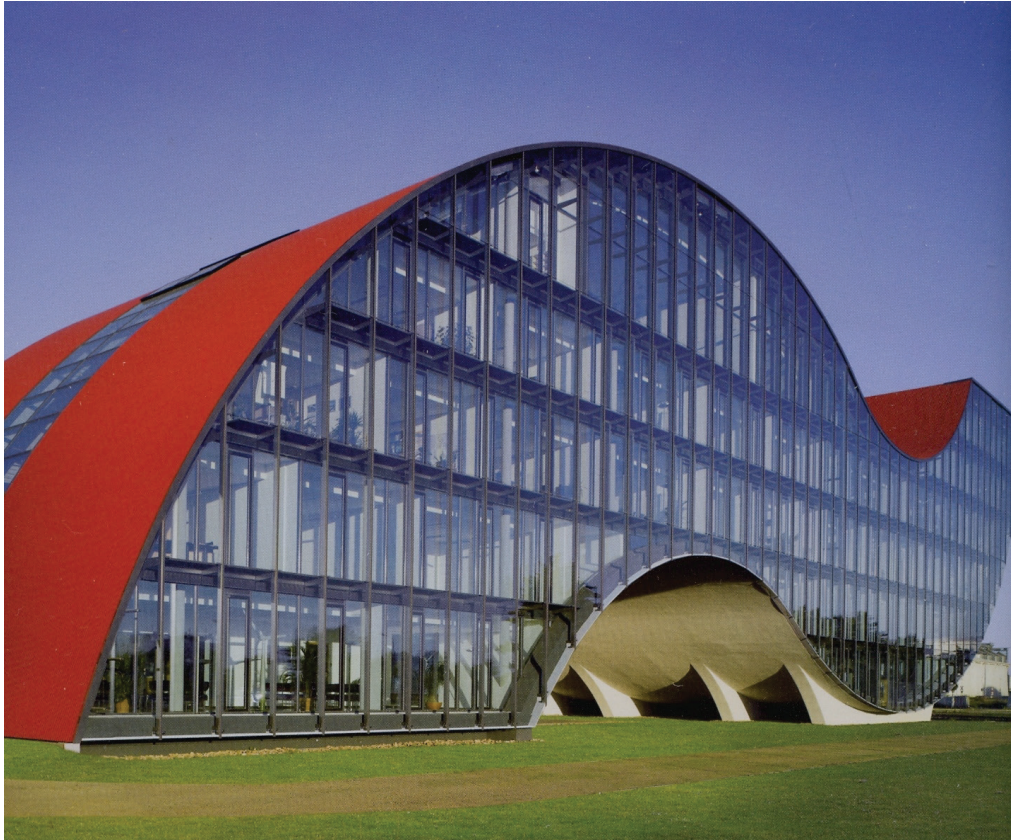
4.2. att. Administratīvā ēka Magdeburgā (Vācija). Formu elegance un ēkas energoefektivitātes augstie rādītāji ir piesaistījuši arhitektu un inženieru uzmanību „Schuco” firmas risinājumiem. (Schuco risinājums)
