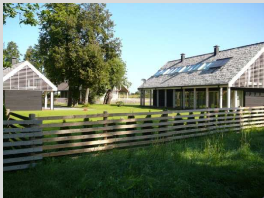
Ēkās izmantoti videi draudzīgi materiāli, uz jumtiem uzstādīti solārie paneļi, Ekociemats Trenči Latvijā
