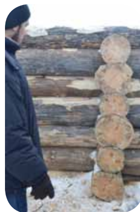
Ekociemata Kovcheg darba grupa ceļ mājas saskaņā ar tradicionālo būvniecības tehniku, izmantojot asis. Irina Popova fotogrāfija
