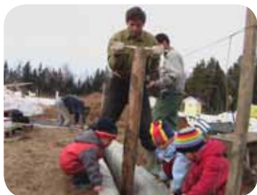
Kopīga mājas būvniecība. Fotogrāfija no ekociemata Kovcheg arhīva
