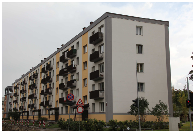
Ēka renovācijas laikā 2011. gadā
