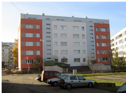
Ēka renovācijas laikā 2010. gadā
