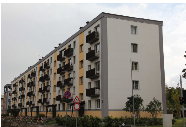
Ēka renovācijas laikā 2011. gadā
