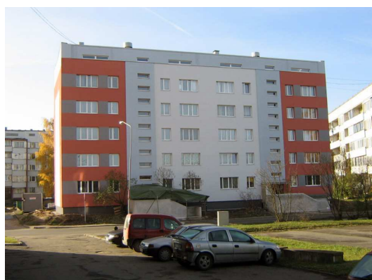
Ēka renovācijas laikā 2010. gadā
