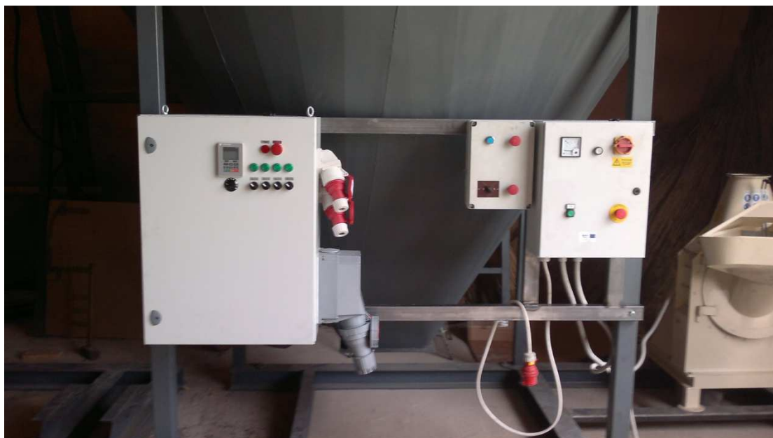
27. att. Smalcinātāj prototipa vadības bloku montāža
