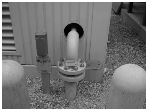
5.7.att. PSA biometāna iekārta (pa kreisi) un biometāna stacijas savienojums ar dabasgāzes tīklu Plīningā, Vācijā (RUTZ, 2007)
