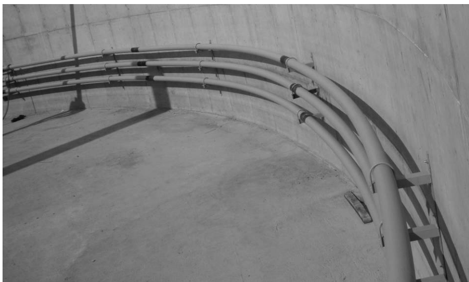
7.17.att. Bioreaktorā ievietotas apsildes caurules (AGRINZ GmbH, 2008)
