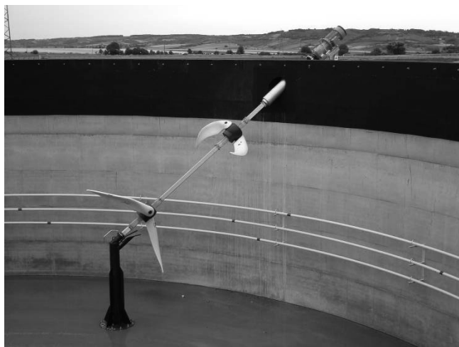
7.23.att. Lāpstiņu maisītājs (pa kreisi) un iegremdējams motora propellera dzinējs (pa labi) (AGRINZ GmbH, 2006)
