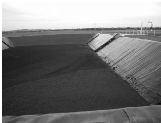
7.34.att. Atvērti nosēdbaseini pārstrādātā substrāta uzglabāšanai (AGRINZ GmbH, 2006)
