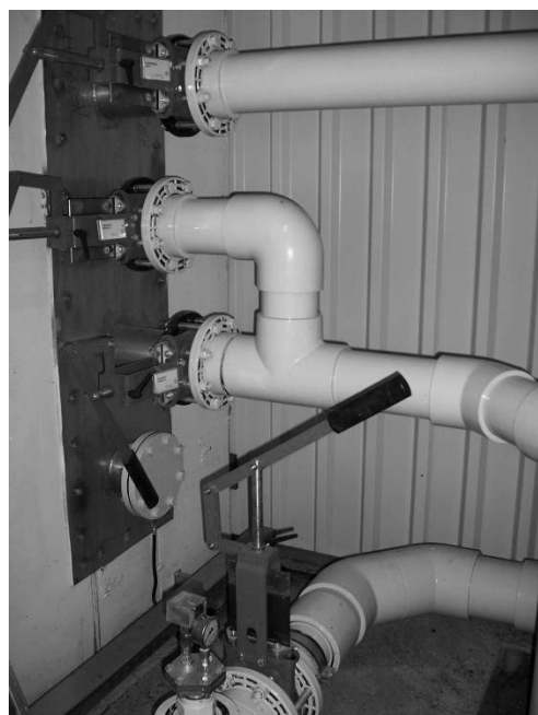
7.8.att. Apturēšanas ventiļi (pa kreisi) un sūkņēšanas sistēma (pa labi) (RUTZ, 2006)
