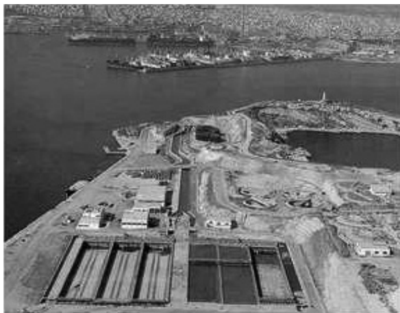
4.11.att. Notekūdeņu attīrīšanas stacija Psitalijā, Grieķijā (EYDAPSA, 2008)
