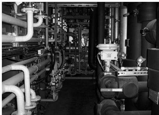
5.7.att. PSA biometāna iekārta (pa kreisi) un biometāna stacijas savienojums ar dabasgāzes tīklu Plīningā, Vācijā (RUTZ, 2007)
