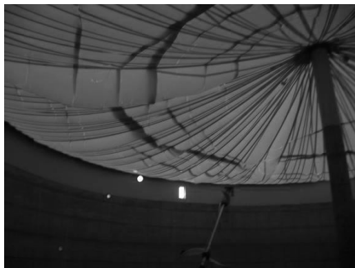
7.26.att. Gāznecaurlaidīga membrāna no tvertnes iekšpuses (pa kreisi) (AGRINZ GmbH, 2006). Bioreaktora pārsegums, kas aprīkots ar izplešanās tīklu (pa labi) (RUTZ, 2006)
