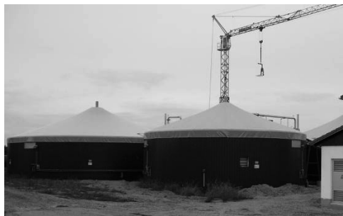
7.19.att. Vertikālie bioreaktori, kas apsegti ar gāznecaurīdīgu membrānu (AGRINZ GmbH, 2008 – pa kreisi & RUTZ, 2006 – pa labi)
