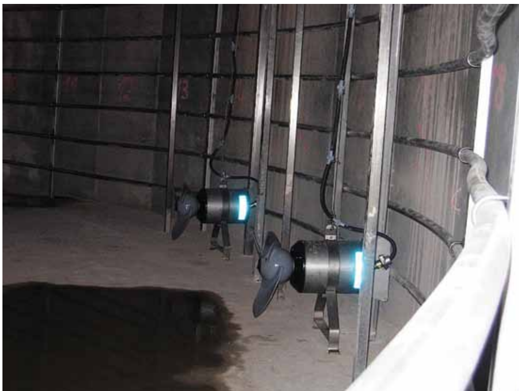
1.16.attēls. Bioreaktorā iegremdēti propellera maisītāji.
