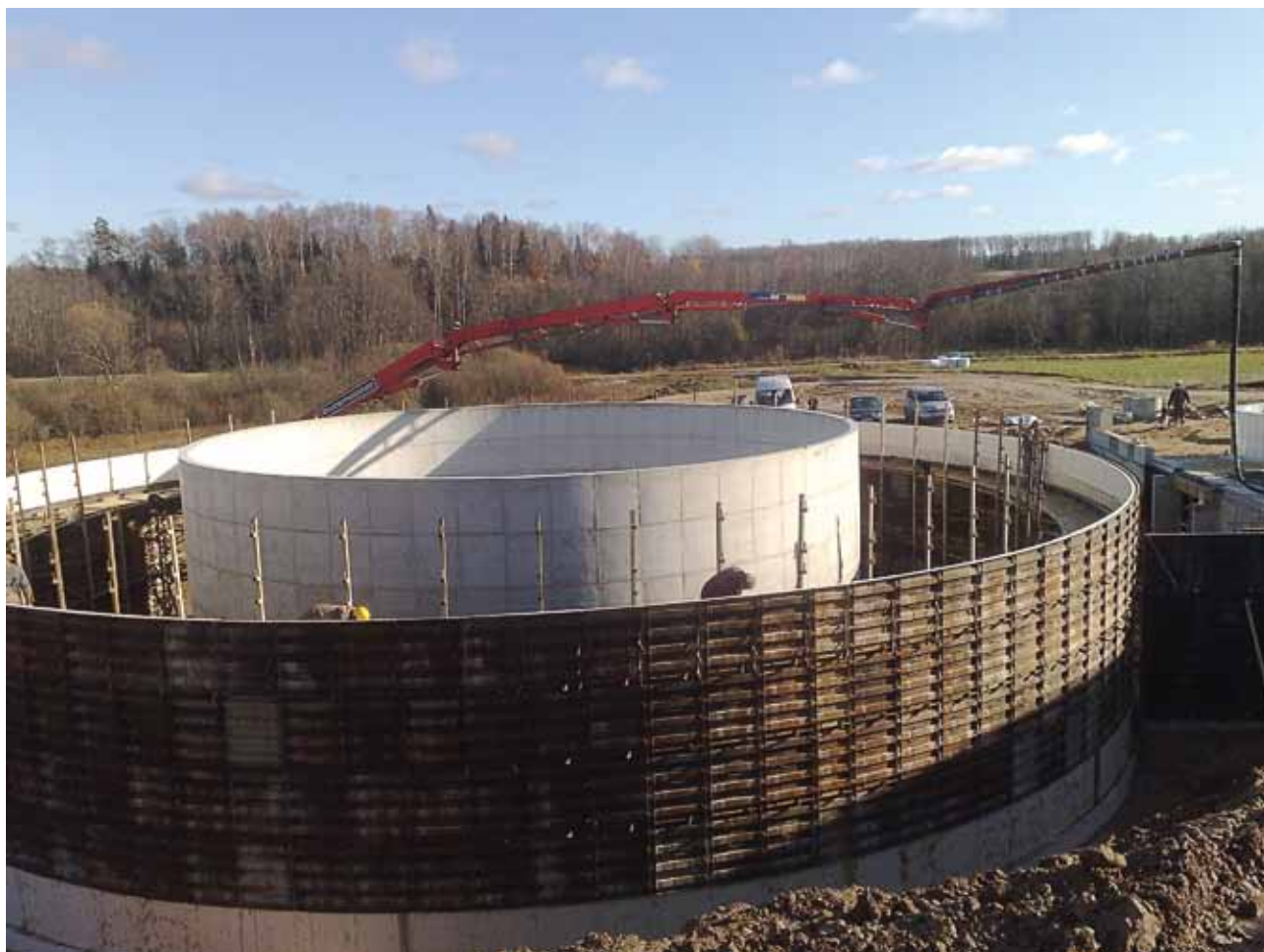
Biogāzes stacijas «Nopa Ltd» celtniecības gaita
