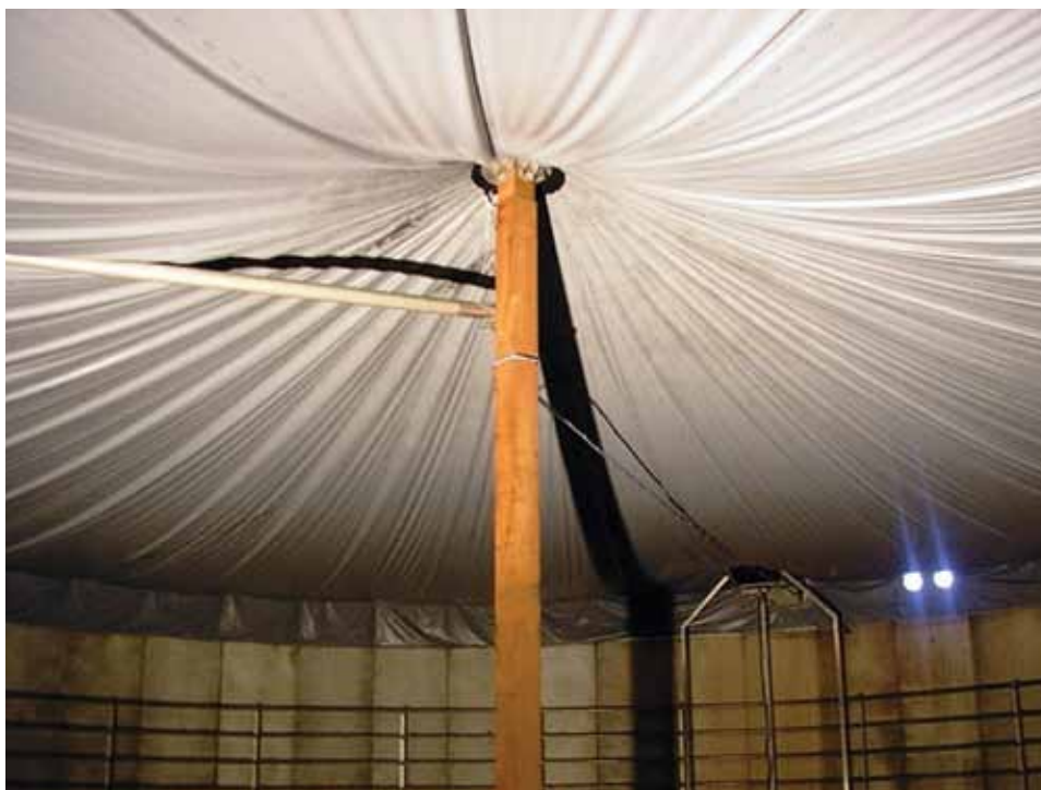
1.21.attēls. Bioreaktors ar membrānu gāzes uzkrāšanai.
