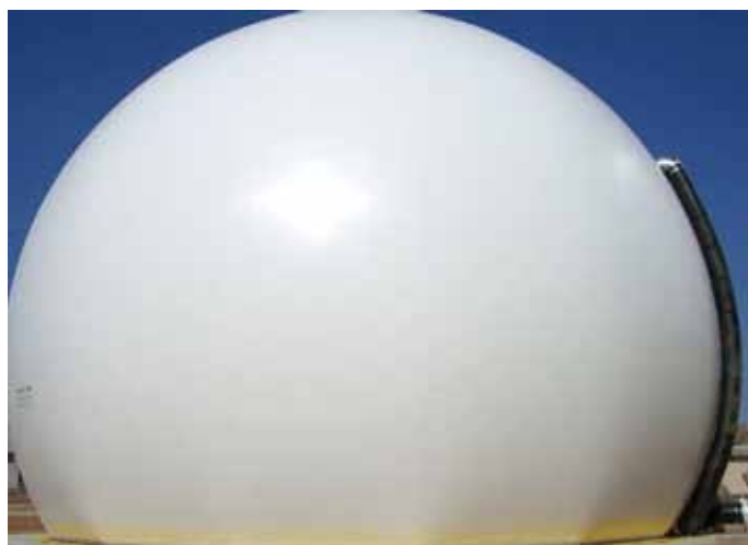
1.22.attēls Atsevišķi stāvoša gāzes krātuve ar dubultmembrānu.
