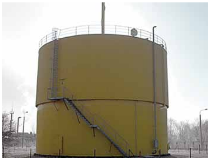
1.23.attēls. Atsevišķi stāvoša no tērauda izgatavota biogāzes krātuve
