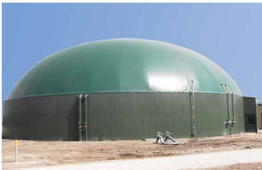
1.19.attēls. Vertikālais bioreaktors ar izbūvētu dubultmembrānas biogāzes krātuvi (Binowa Umwelttechnik un Biolak Baltic).
