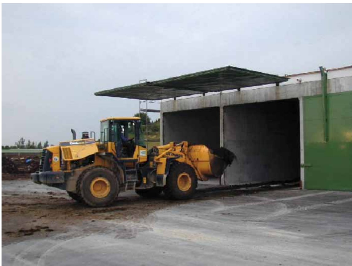
1.5.attēls. Kameras tipa sausās fermentācijas iekārta
