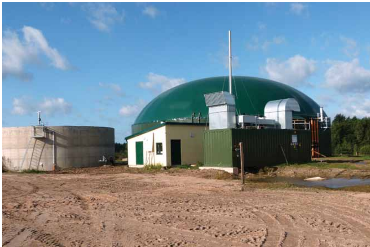
Biogāzes stacija «BP Energy»
