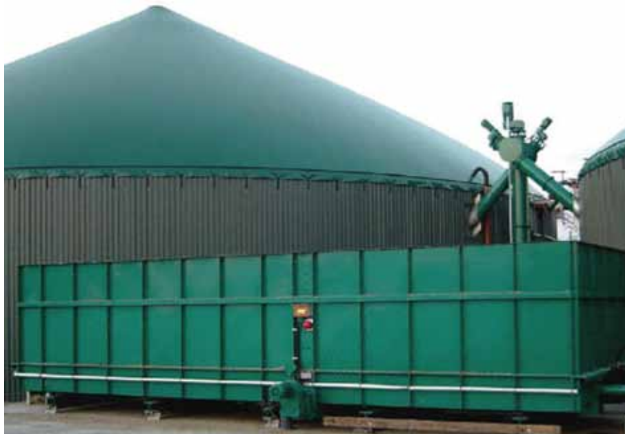
1.9.attēls. Lielām ražotnēm piemērota cietās biomasas padeves iekārta.
