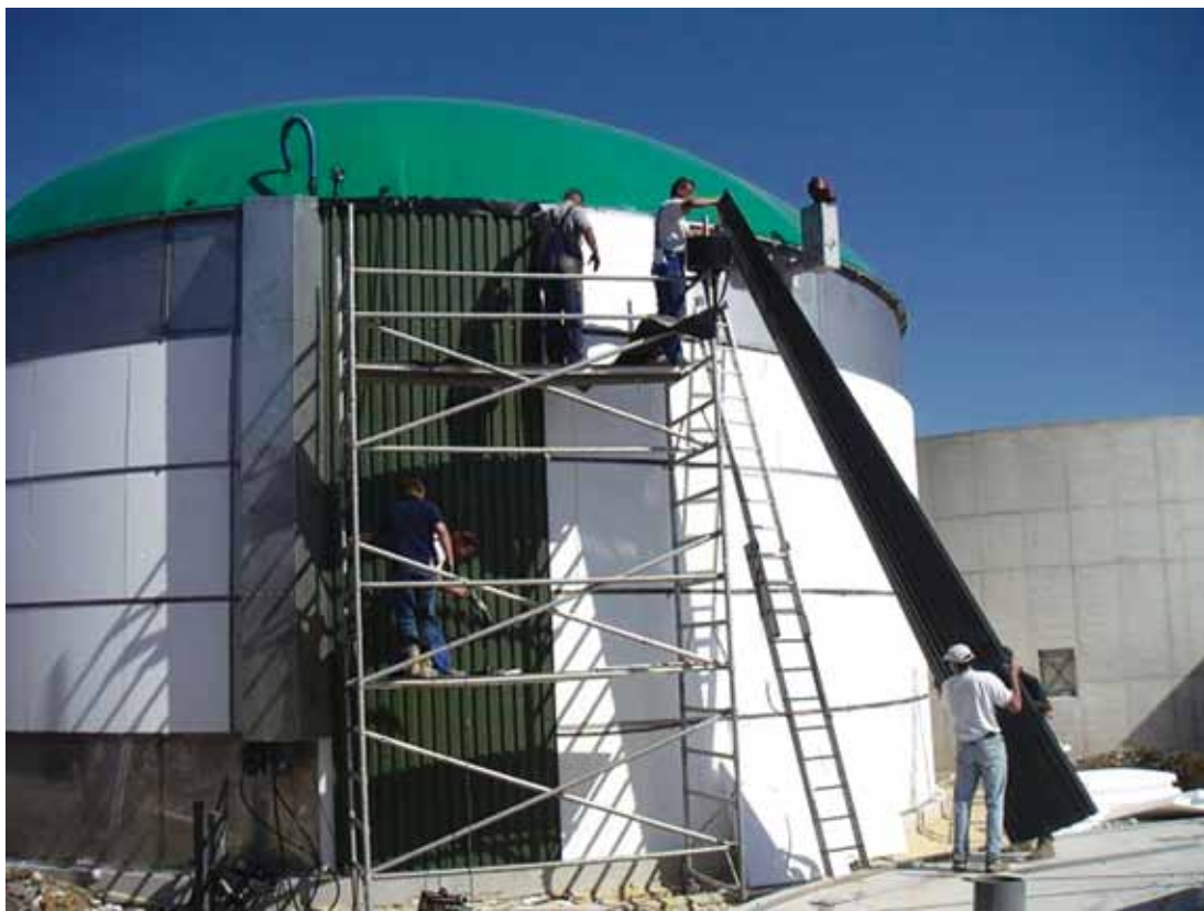
1.20.attēls. Bioreaktora siltumizolācijas ierīkošana.
