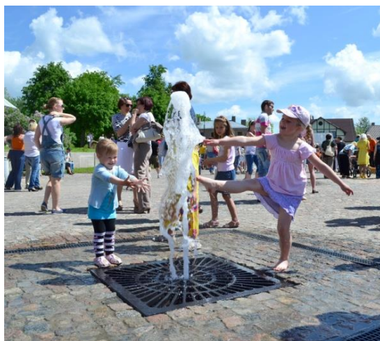
Vecpilsētas laukums pēc rekonstrukcijas
