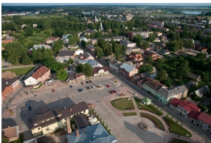
Vecpilsētas laukums pēc rekonstrukcijas
