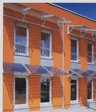
Enerģijas uzkrāšanas fotovoltāžas paneļi uz jumteņu formā – arhitektoniski veiksmīgs dizaina elementu izvietojums ēkas fasādē
