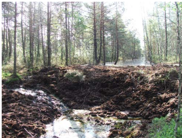
5.3.attēls. No kūdras veidots dambis kontūrgrāvim Cenas tīrelī (foto A. Indriksons).
